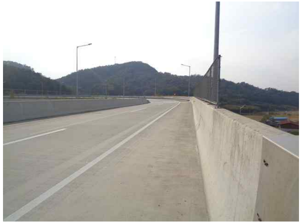
교량 상부 전경
