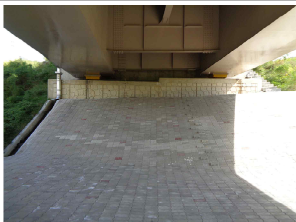
교량 하부 전경
