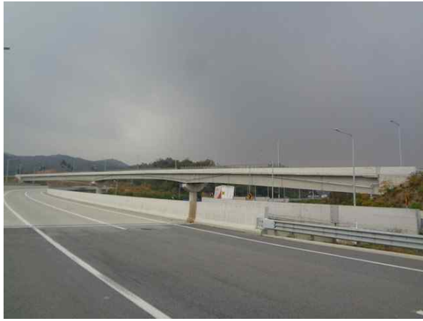
교량 측면 전경
