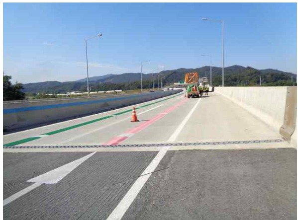
교량 상부 전경
