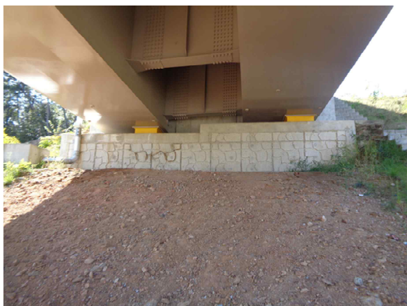
교량 하부 전경
