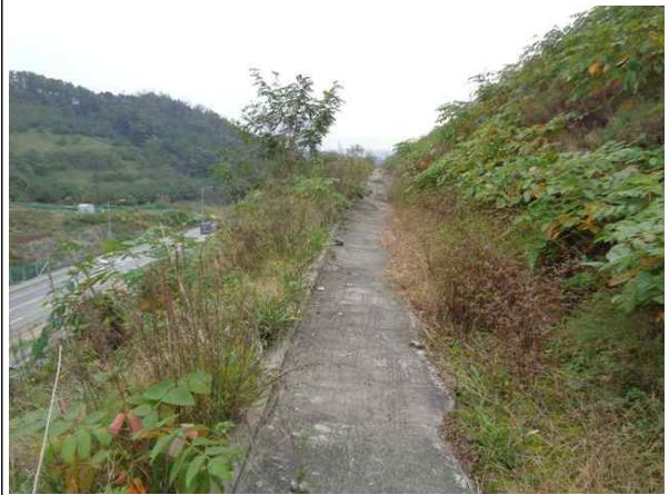
1소단 배수로 전경
