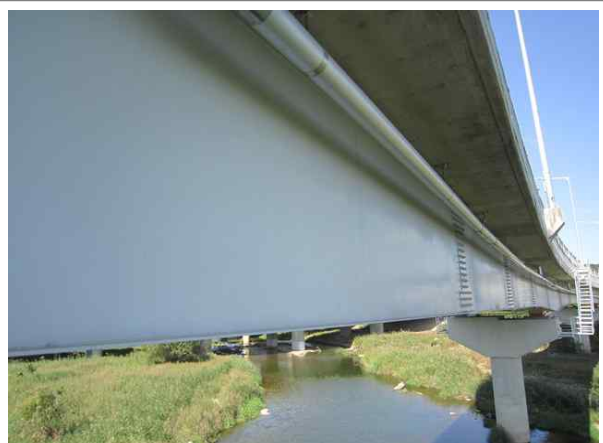
교량 거더 전경
