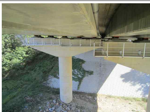
교량 하부 전경
