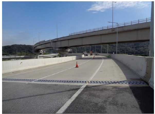
교량 상부 전경
