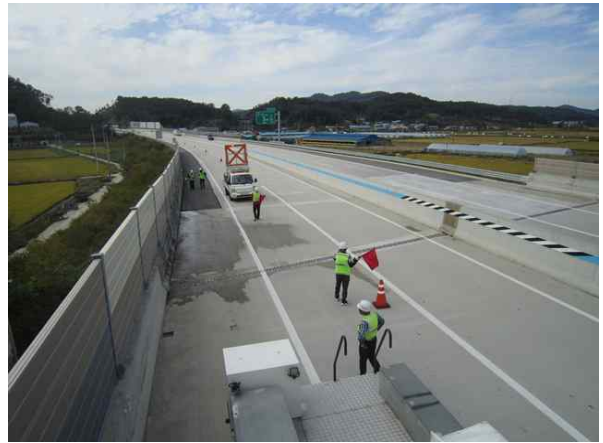
교량 상부 전경
