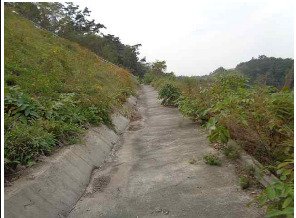
1소단 배수로 전경
