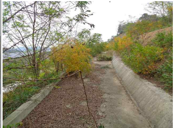
1소단 배수로 전경
