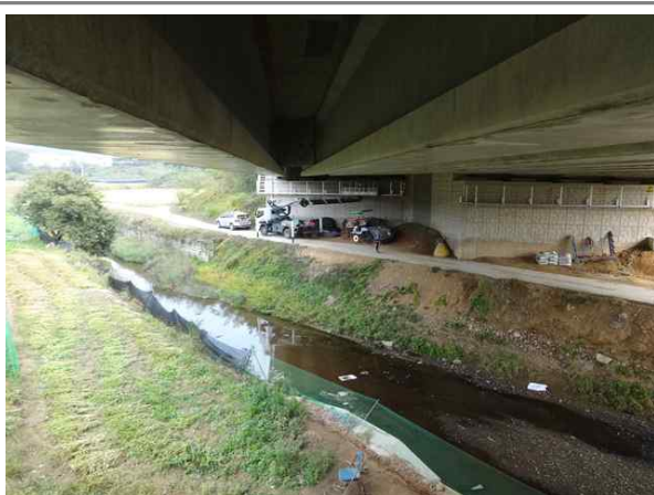
교량 하부 전경
