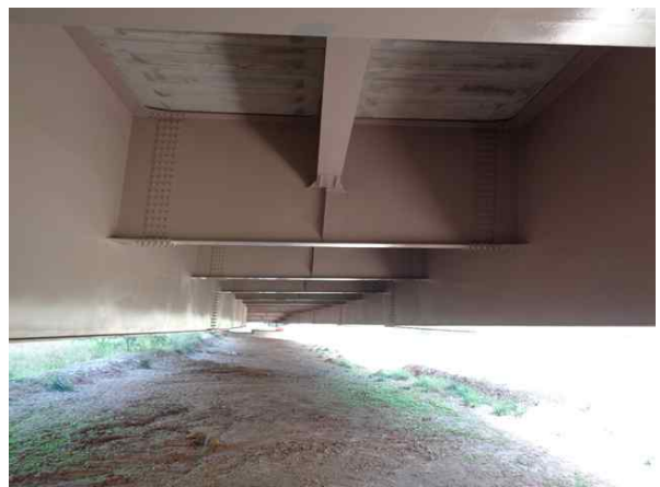
교량 거더 전경
