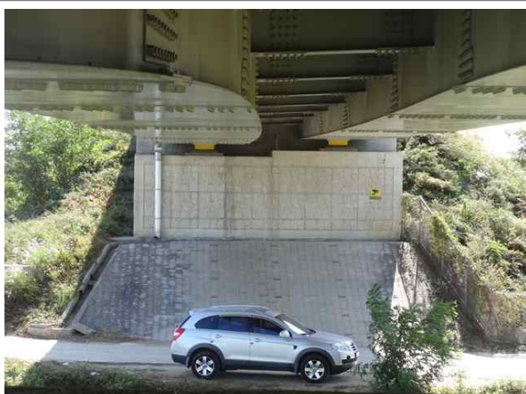
교량 하부 전경
