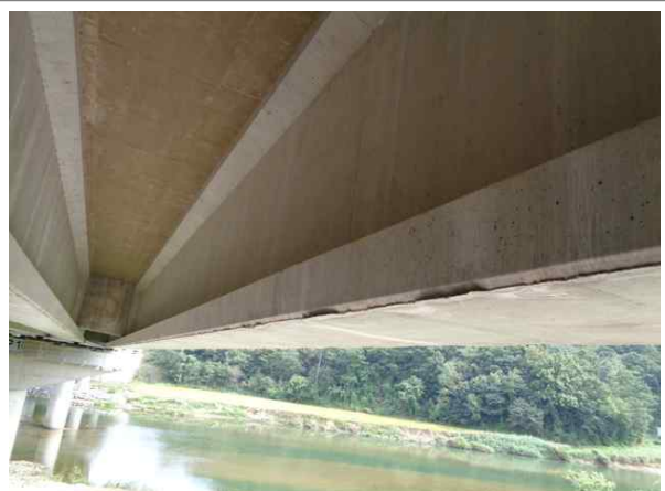
교량 거더 전경
