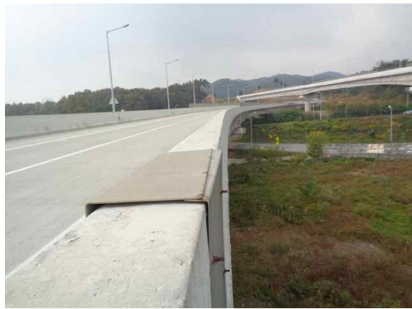
교량 측면 전경
