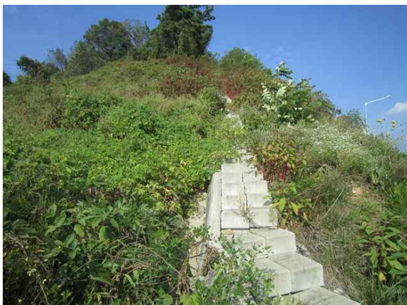
콘크리트 점검계단 전경
