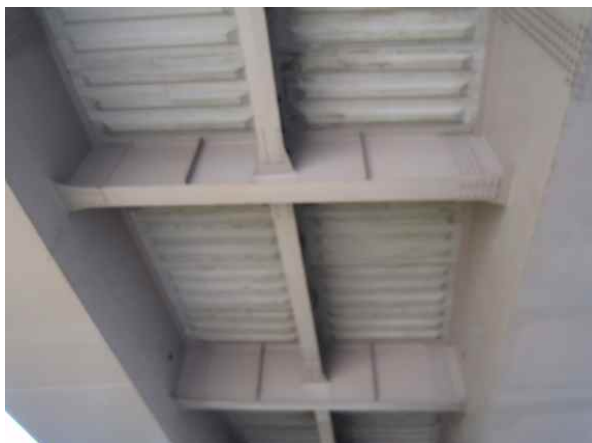
교량 바닥판 전경
