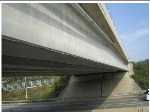
교량 거더 전경
