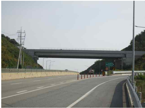
교량 측면 전경
