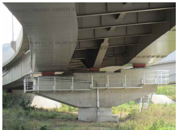
교량 하부 전경
