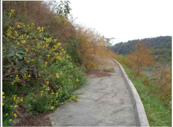
1소단 배수로 전경
