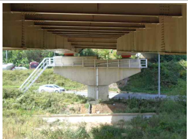
교량 하부 전경
