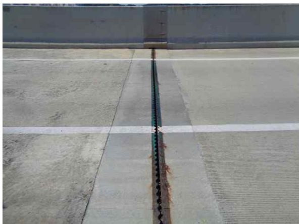
교량 상부 전경
