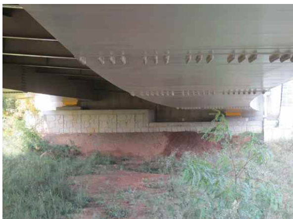
교량 하부 전경
