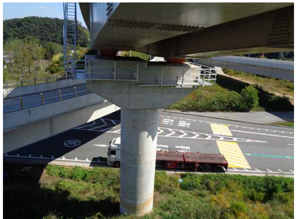
교량 하부 전경
