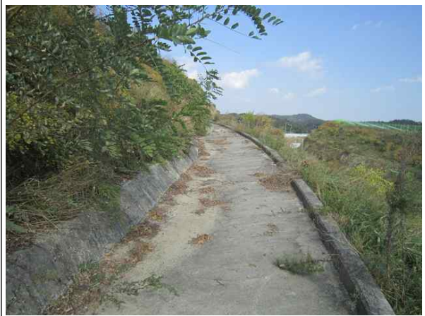
1소단 배수로 전경
