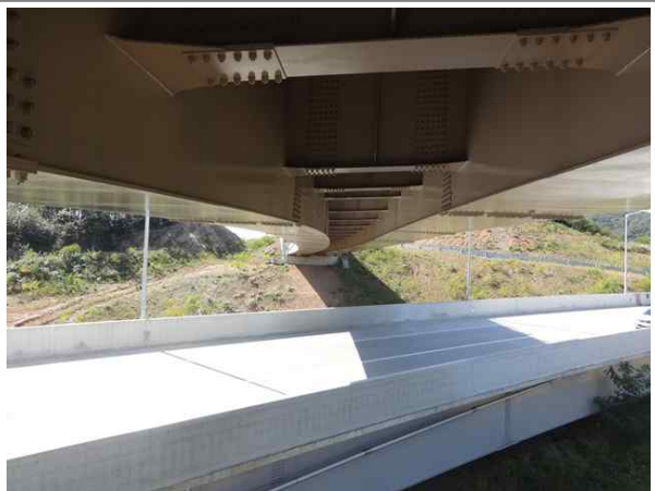
교량 거더 전경
