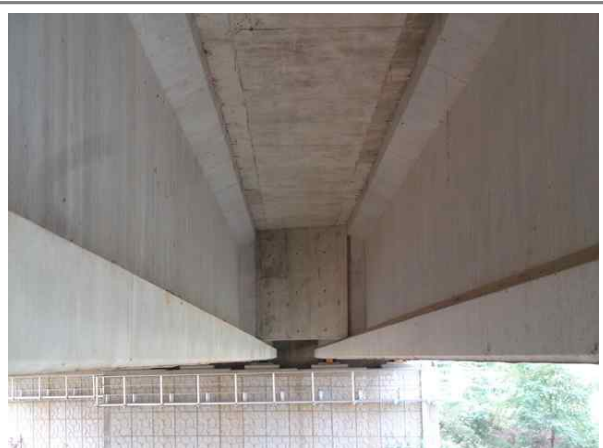
교량 거더 전경
