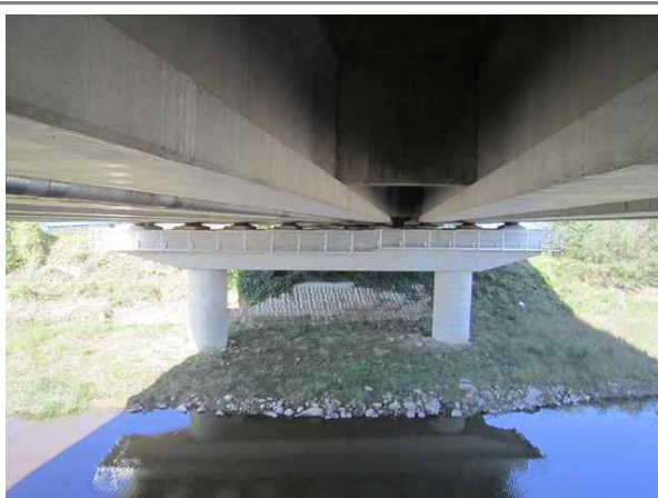
교량 하부 전경
