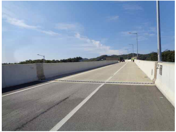
교량 상부 전경
