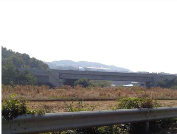
교량 측면 전경
