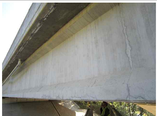
교량 거더 전경
