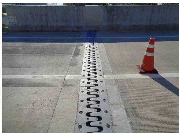
교량 상부 전경
