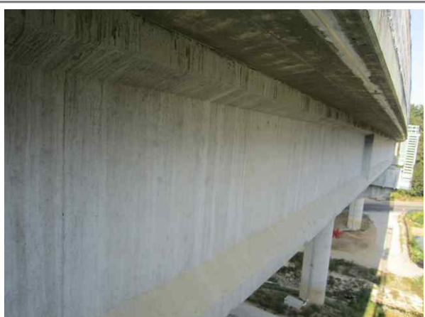
교량 거더 전경
