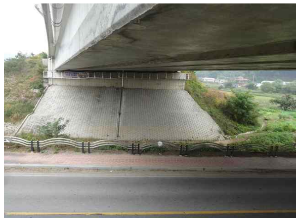
교량 하부 전경
