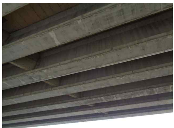
교량 거더 전경
