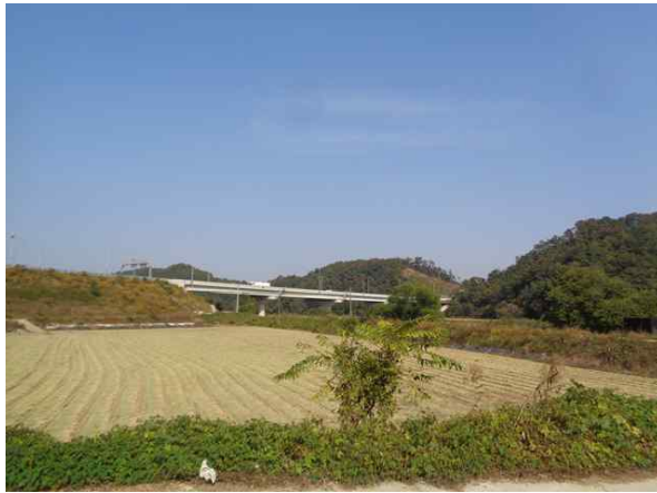
교량 측면 전경
