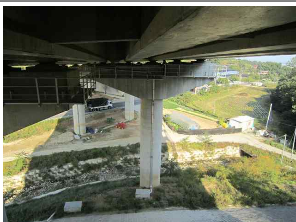
교량 하부 전경
