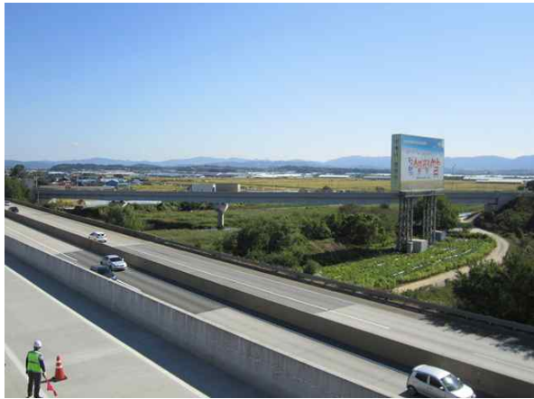
교량 측면 전경
