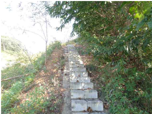
콘크리트 점검계단 전경
