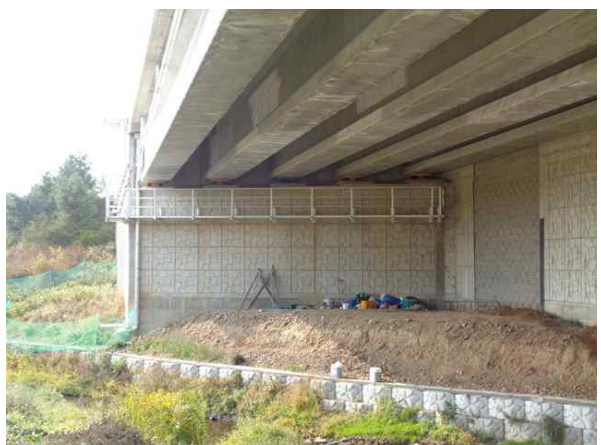
교량 하부 전경
