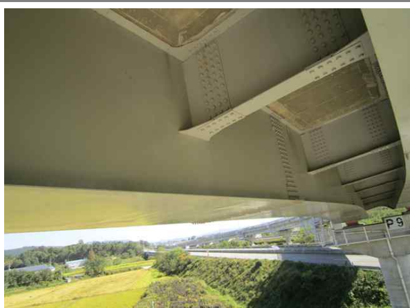
교량 거더 전경
