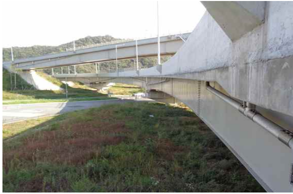
교량 측면 전경
