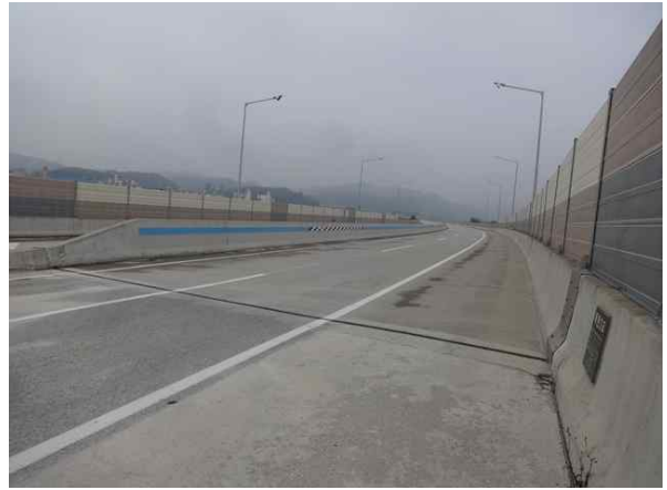
교량 상부 전경
