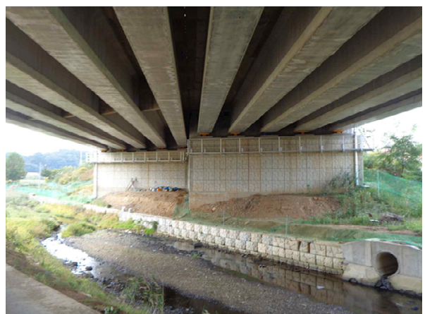
교량 하부 전경
