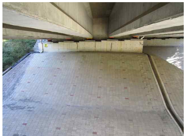
교량 하부 전경
