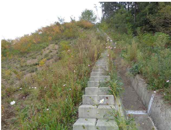
콘크리트 점검계단 전경
