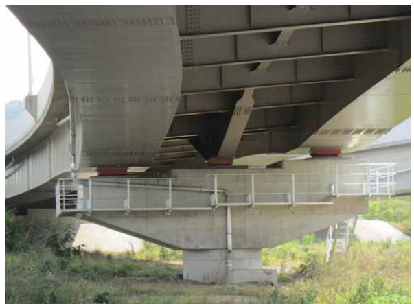
교량 거더 전경
